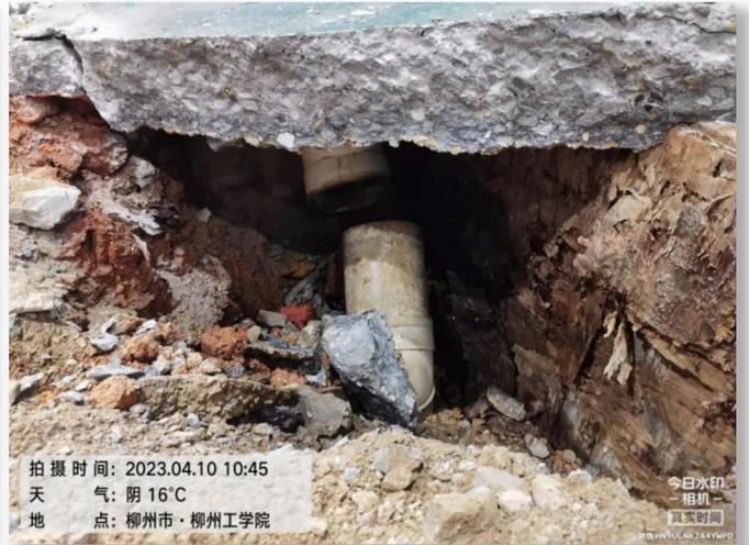
风雨操场室内地坪局部下沉部分原因是由雨水管断裂、雨水长期浸泡导致
