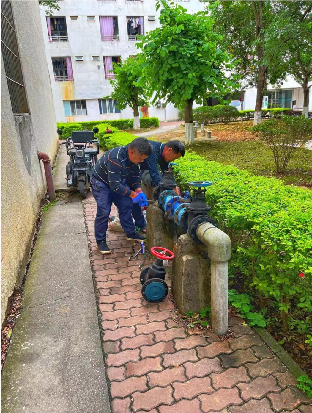
利用修复漏水点的窗口时间更换阀门
