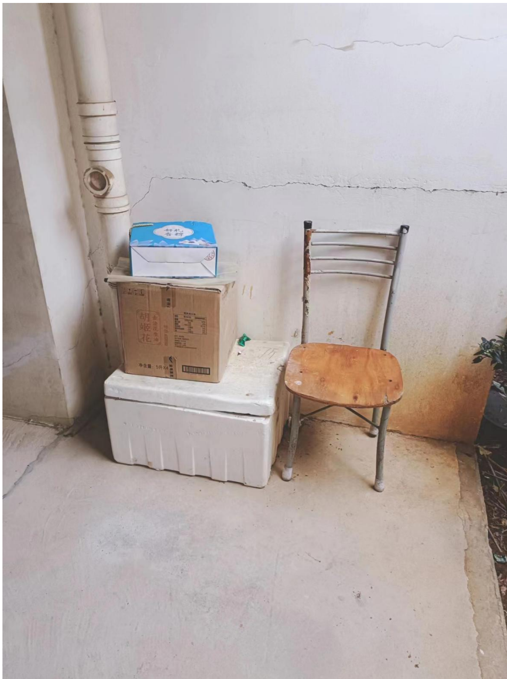
8 栋 1 楼架空层通道
